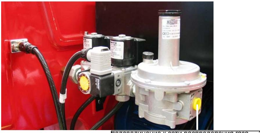
После монтажа газовой рампы выполнить электрические подсоединения ее компонентов (клапанов, реле давления).
